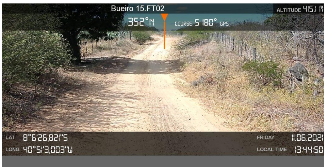
IMAGEM DO BUEIRO 02
