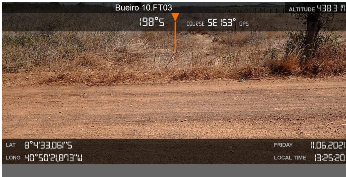
IMAGEM DO BUEIRO 07
